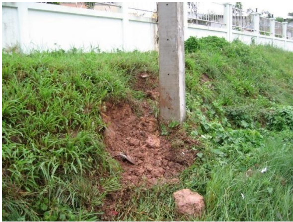
รูปที่ 3-10 หลักฐานการชนที่คันดินบริเวณเสาไฟฟ้า
