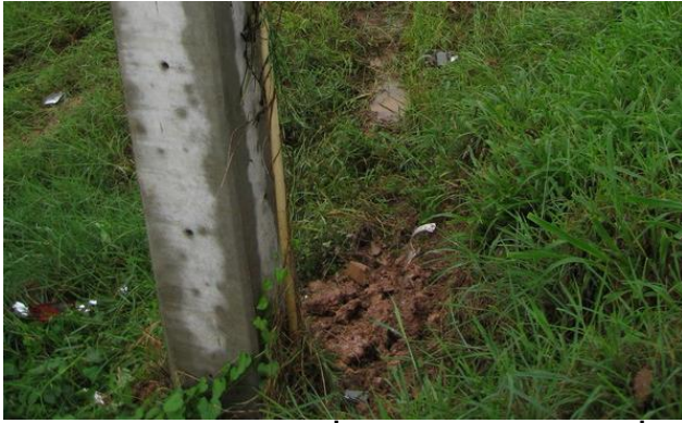
รูปที่ 3-9 หลักฐานการชนที่เสาไฟฟ้า
