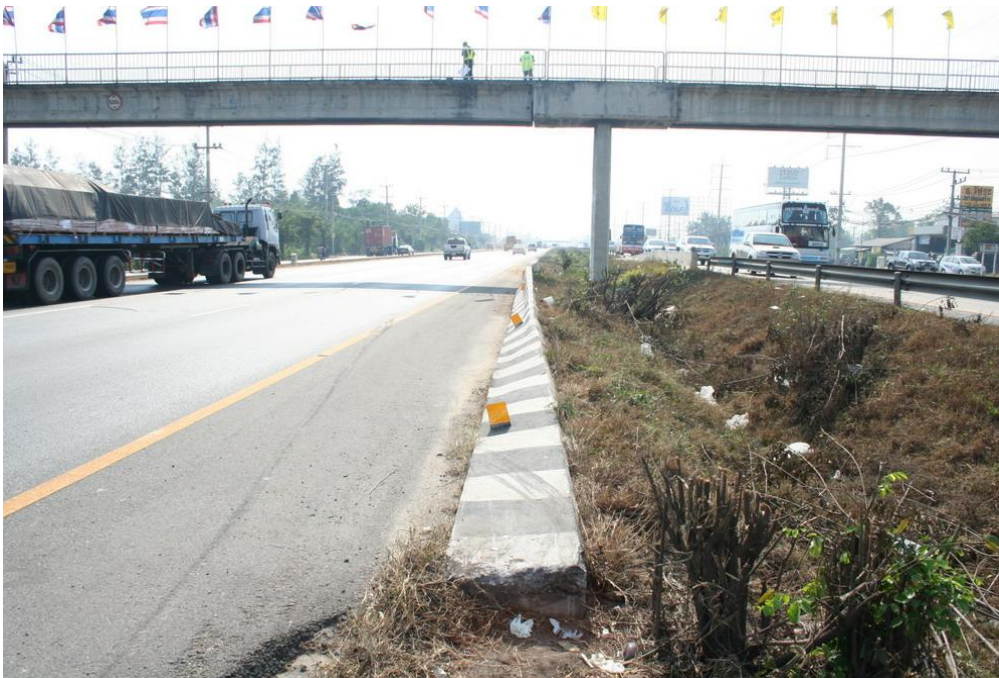
รูปที่ 3-11 เนินปลายกำแพงคอนกรีต
