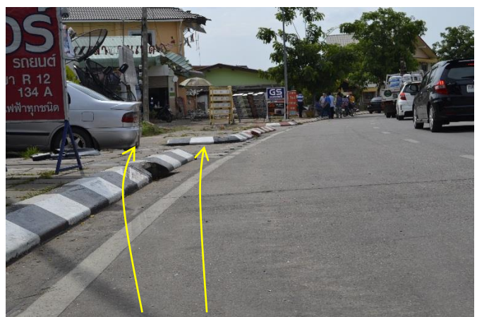
รูปที่ 34 รอยล้อของรถโดยสาร แสดงให้เห็นเส้นทางที่รถโดยสารหลุดออกจากผิวจราจร
