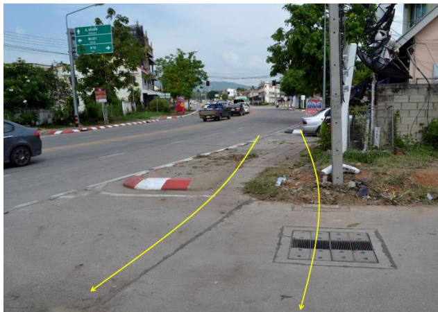
รูปที่ 34 รอยล้อของรถโดยสาร แสดงให้เห็นเส้นทางที่รถโดยสารหลุดออกจากผิวจราจร
