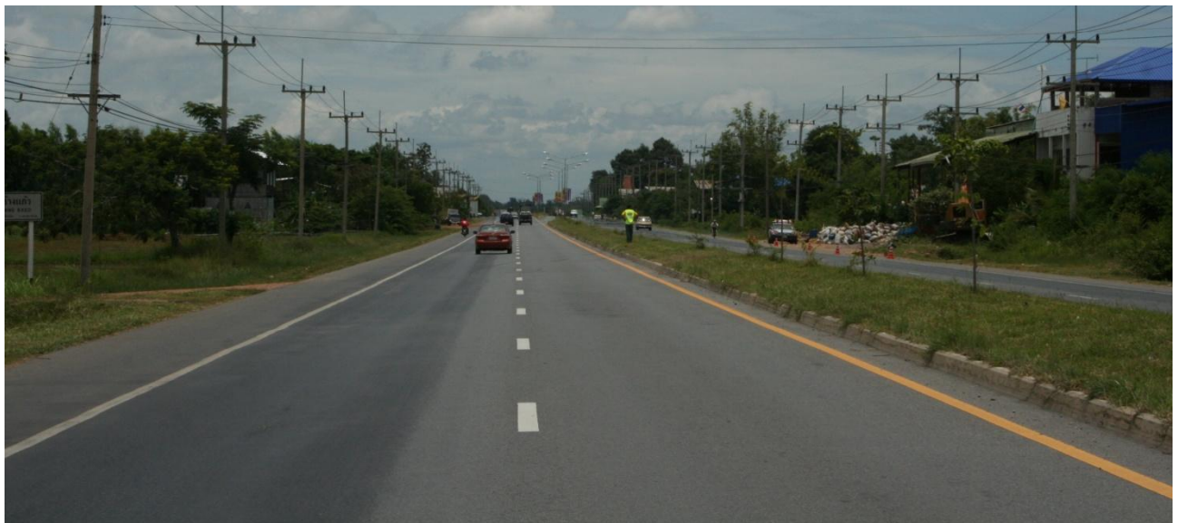
รูปที่ 3-11 ช่วงถนนระยะทางยาวก่อนถึงจุดเกิดเหตุ
